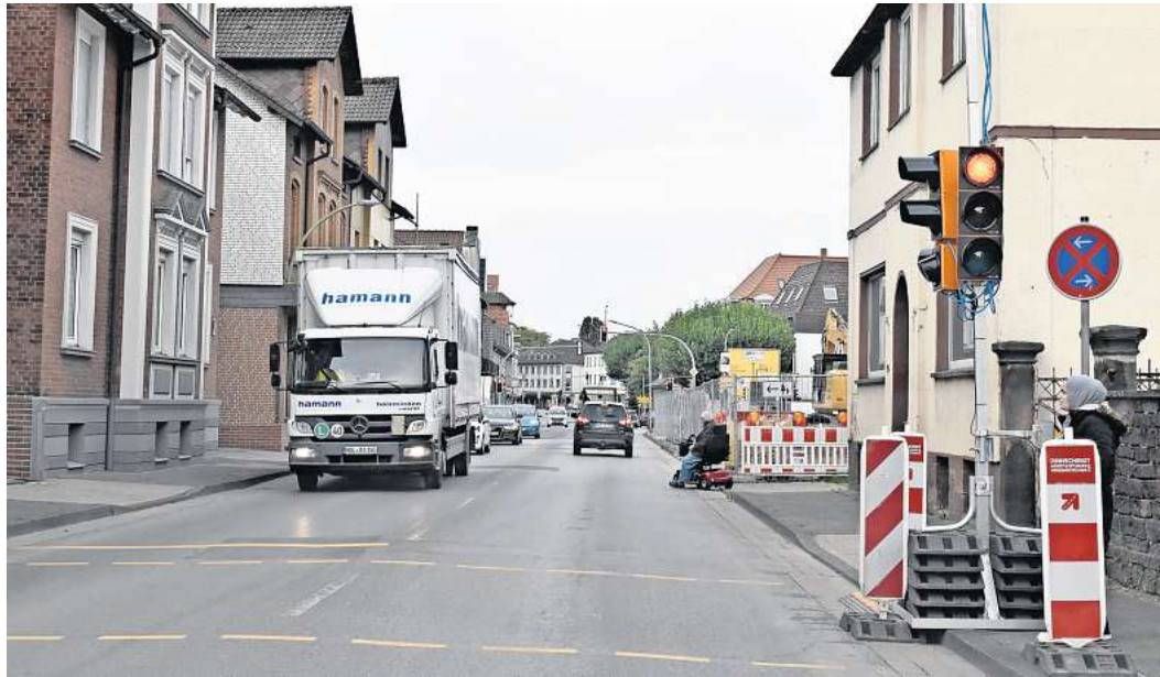
In der Fürstenberger Straße wurde eine Fußgängerampel aufgestellt, weil der Gehweg an der Baustelle nicht nutzbar ist.
