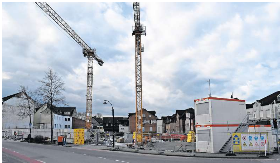
Stillstand auf der Baustelle. Die WSDN Holzminden GmbH als Bauherrin mit Sitz in Vechta will in wenigen Wochen nun ohne Generalübernehmer weiterbauen.
