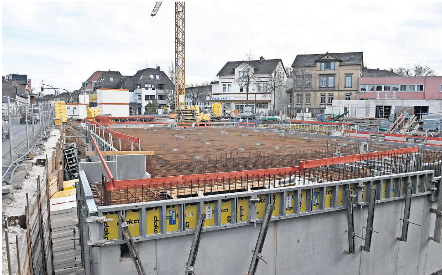
Die Baustelle an der Fürstenberger Straße ruht zurzeit. In vier bis sechs Wochen soll weitergebaut werden.
