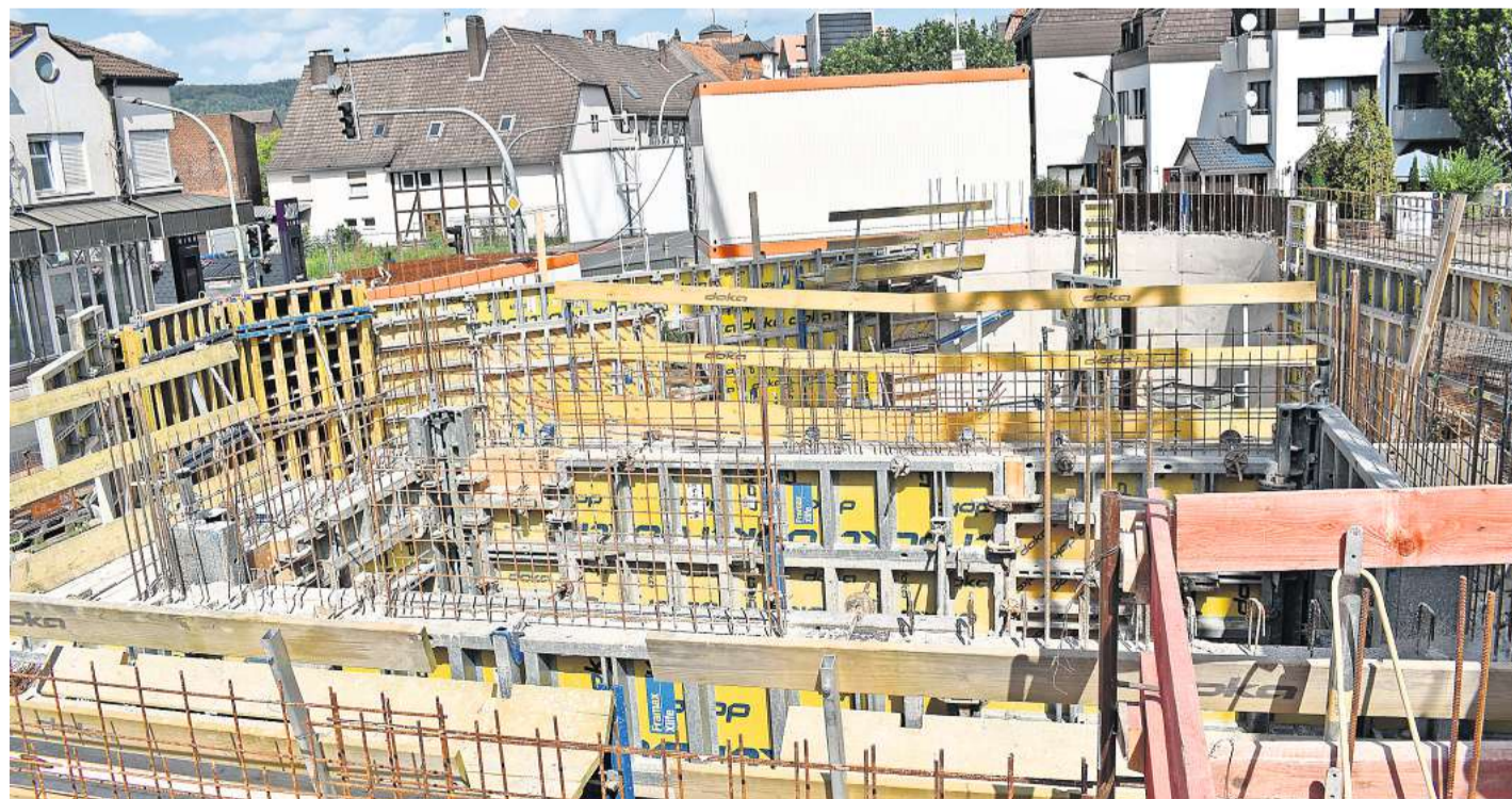
Blick auf Armierungen und Verschalungen: Die Rohbauarbeiten sind im vollen Gang.
