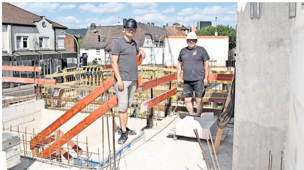
Haben den Durchblick: Bauleiter Olaf Zitzke und Polier Dietmar Rinner (rechts) von der Firma Hartmann Bau aus Borgentreich.
