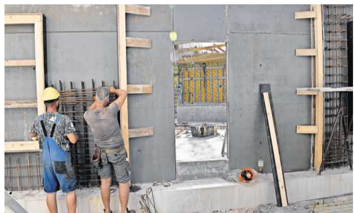
Arbeiter fertigen eine Armierung für eine Wand in Stahlbetonbauweise.
