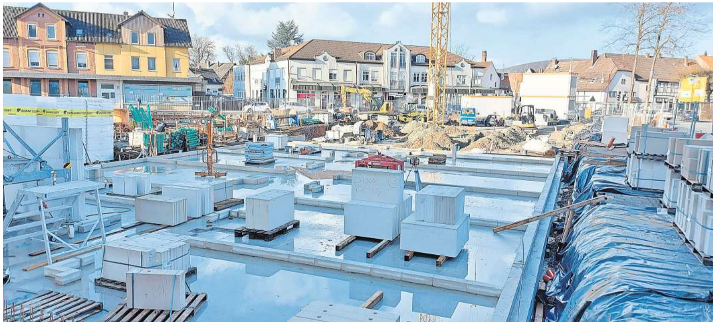
Der Riegel an der Bahnhofstraße: Hier wird auf der Bodenplatte bereits gemauert. Die Zuschnitte der Räume sind schon zu erkennen.
