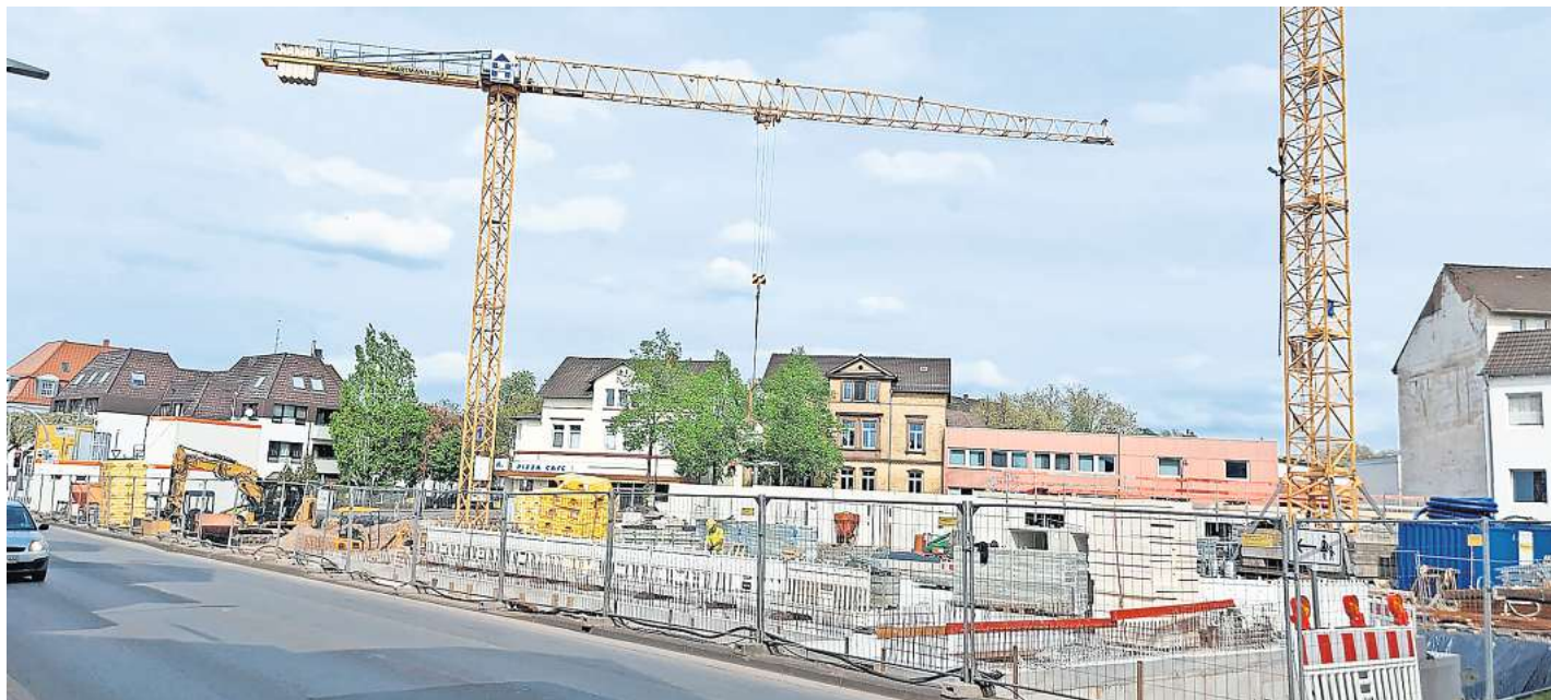
Auf der Wohnpark-Baustelle an der Fürstenberger Straße laufen die Arbeiten seit der letzten April-Woche wieder.
